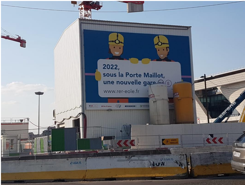
Figure 1 : travaux de réaménagement pour la nouvelle gare Porte Maillot/ Source : Nathanaël Brault.
