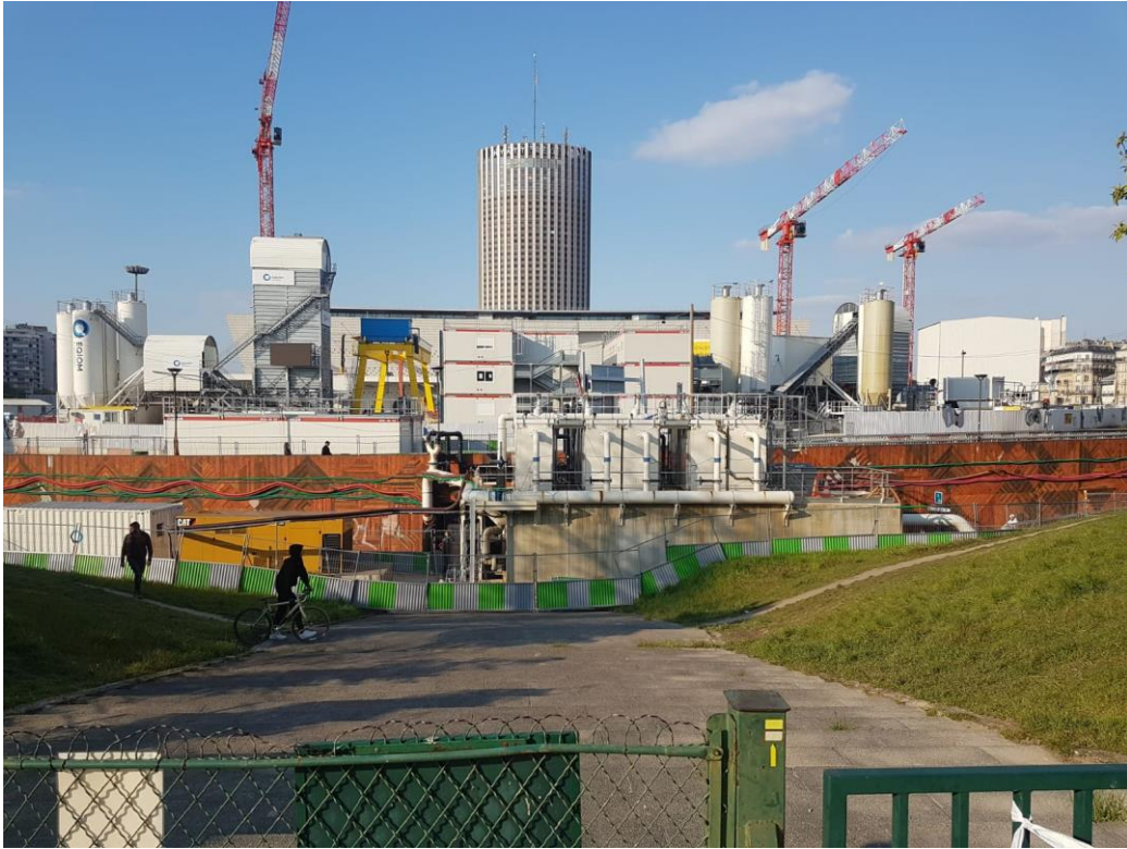
Figure 2 : travaux de réaménagement pour la nouvelle gare Porte Maillot/ Source : Nathanaël Brault.
